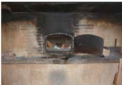
Un des fours à bois du village
